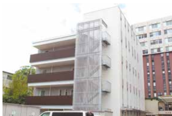
新しい乳児院の外観。現在外周工事がまだ継続しており、年内には全ての工事を終える予定
